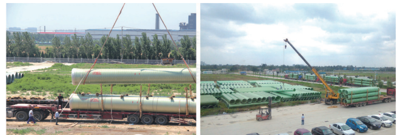
双支点起吊单根玻璃钢管
